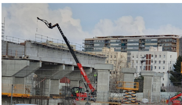
Bigues de formació de la llosa de cobriment del fossat ferroviari.
